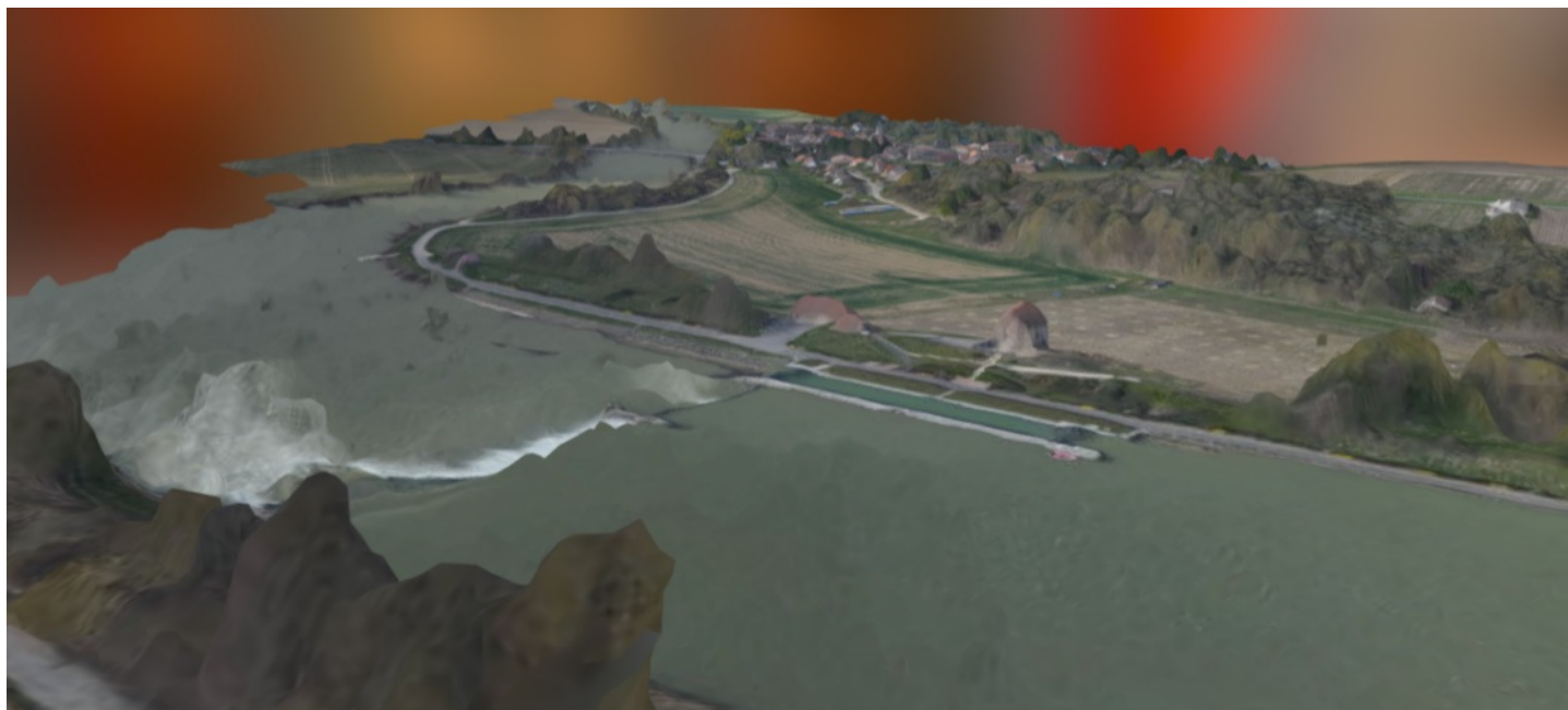
Assemblage 3D de 96 photos verticales sur 3 Line Of Interest à Azy-sur-Marne Nikon D3200 / Pod autostabilisé / ULM hélicoptère Kompres
